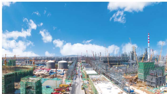
盛虹炼化一体化项目建设现场
