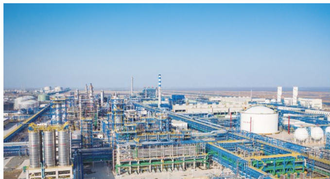
卫星石化项目建设现场
