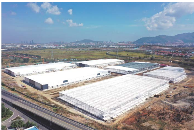
“一带一路”供应链基地(连云港)项目加快建设
