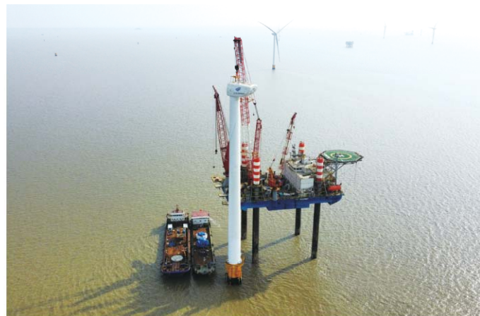
华能灌云海上风电项目施工现场
