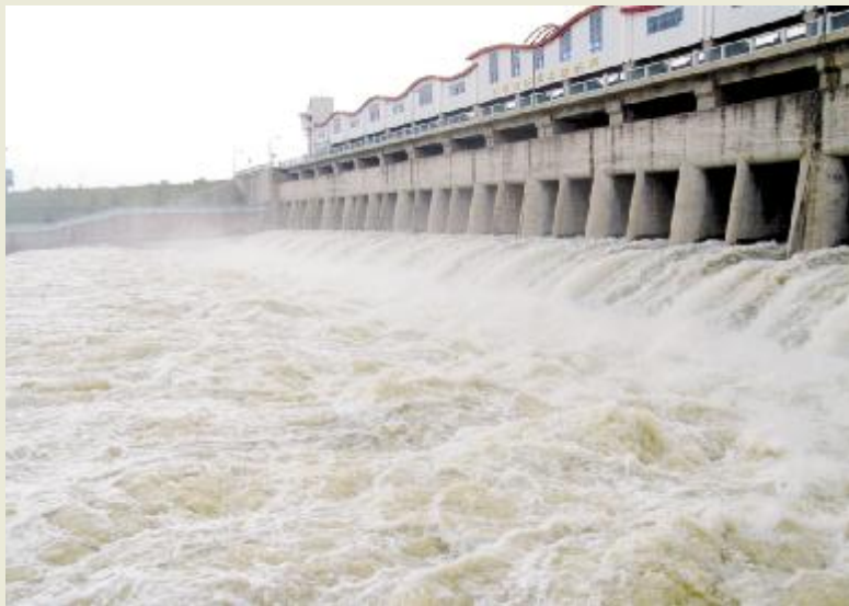
石梁河水库泄洪图
