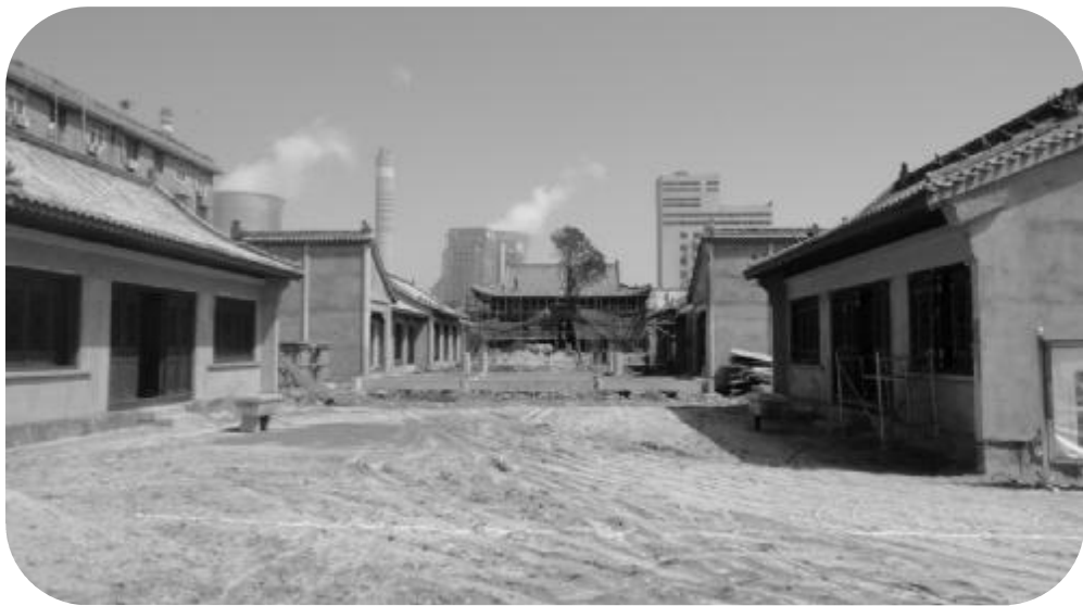
海州城隍庙大殿及配殿土建工程即将竣工
