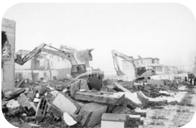
连徐高铁拆迁现场
