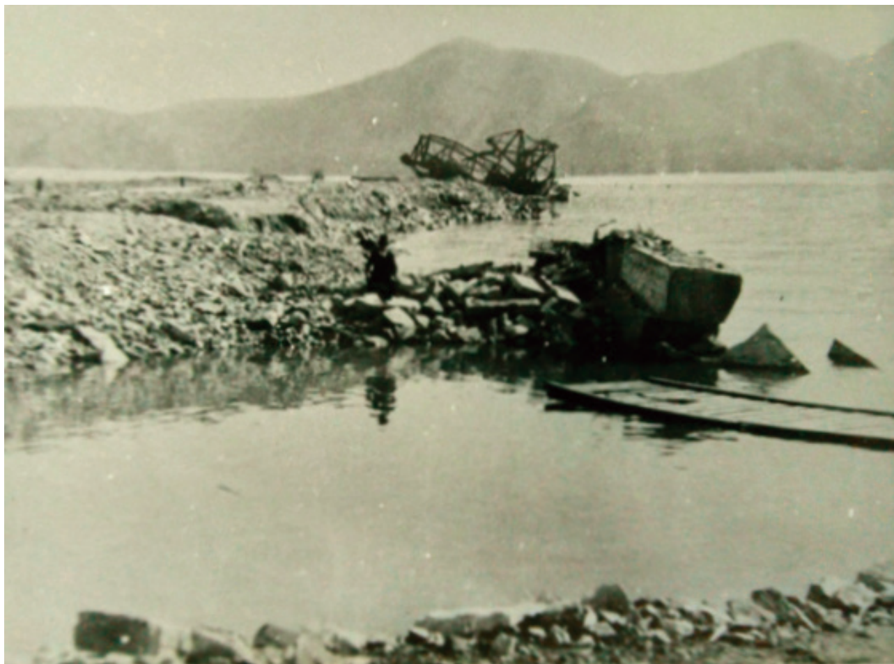
破坏炸毁后的第二码头
